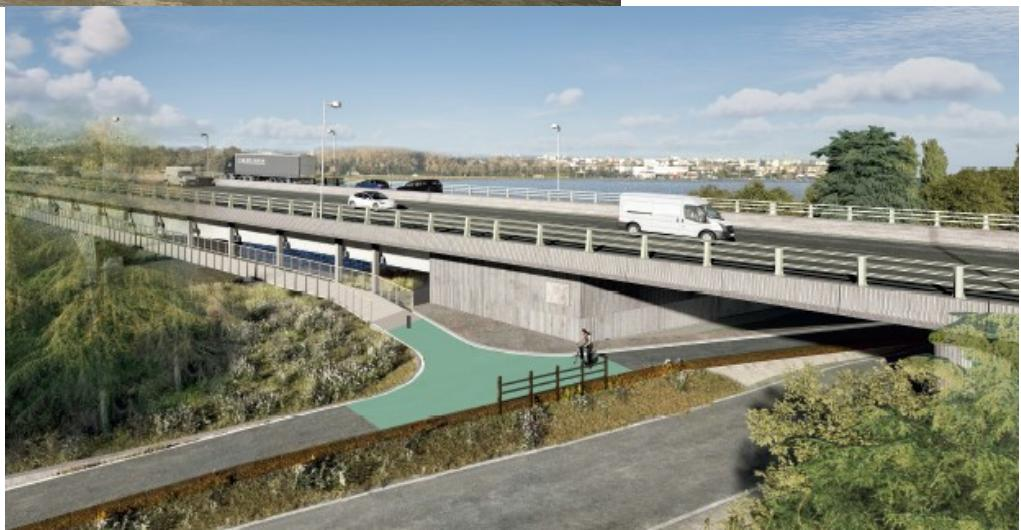
Après une phase de conception du projet validée par la DREAL, les premiers travaux consistant à renforcer la structure du pont pour lui permettre de supporter la charge de cette passerelle ont démarré au printemps 2025.
